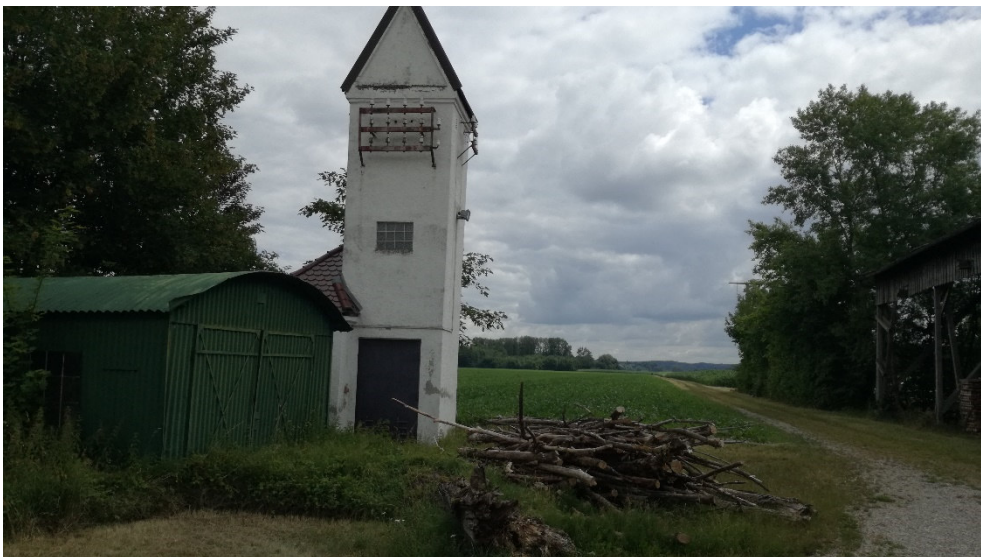
Abbildung 2: In Gut Lindenau wird der Messcontainer nahe dem alten Umspannturm aufgestellt
